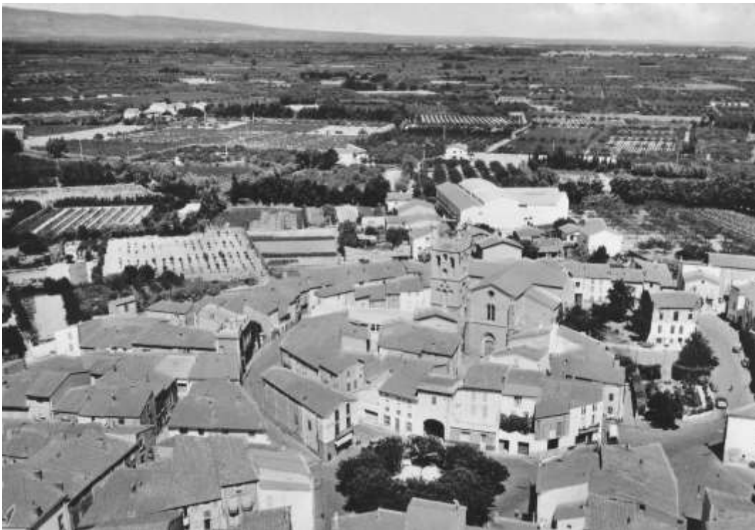
La cellera avant la démolition du presbytère.
